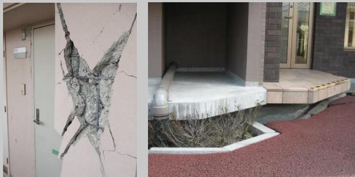
写真左: 玄関脇の壁面損傷(玄関扉の開閉が困難に)
