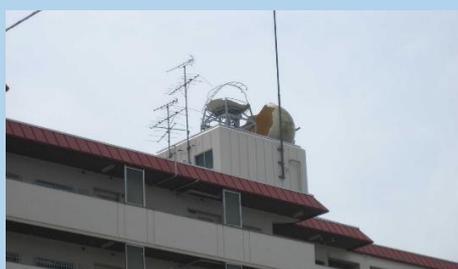
写真左: 受水槽の被害
